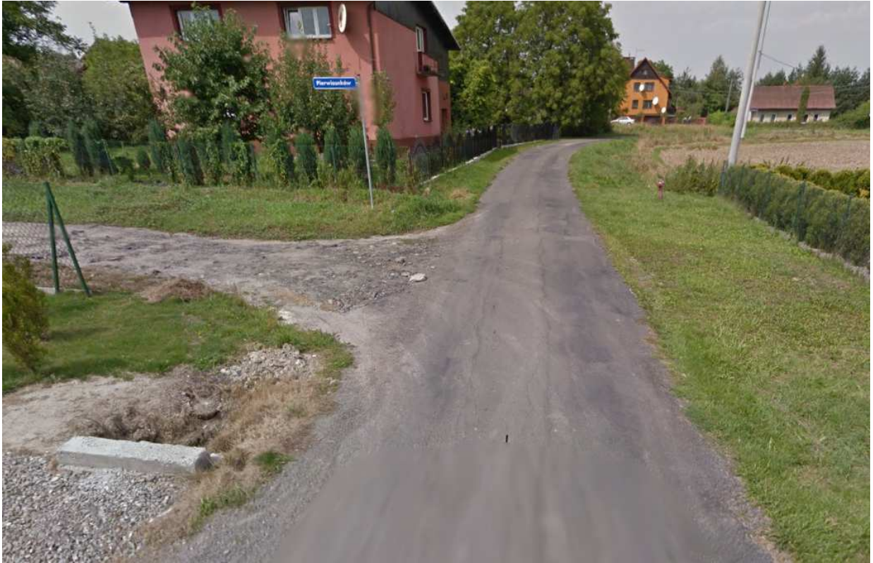
Skrzyżowanie ulicy Przedwiośnie z ulicą Pierwiosnków
