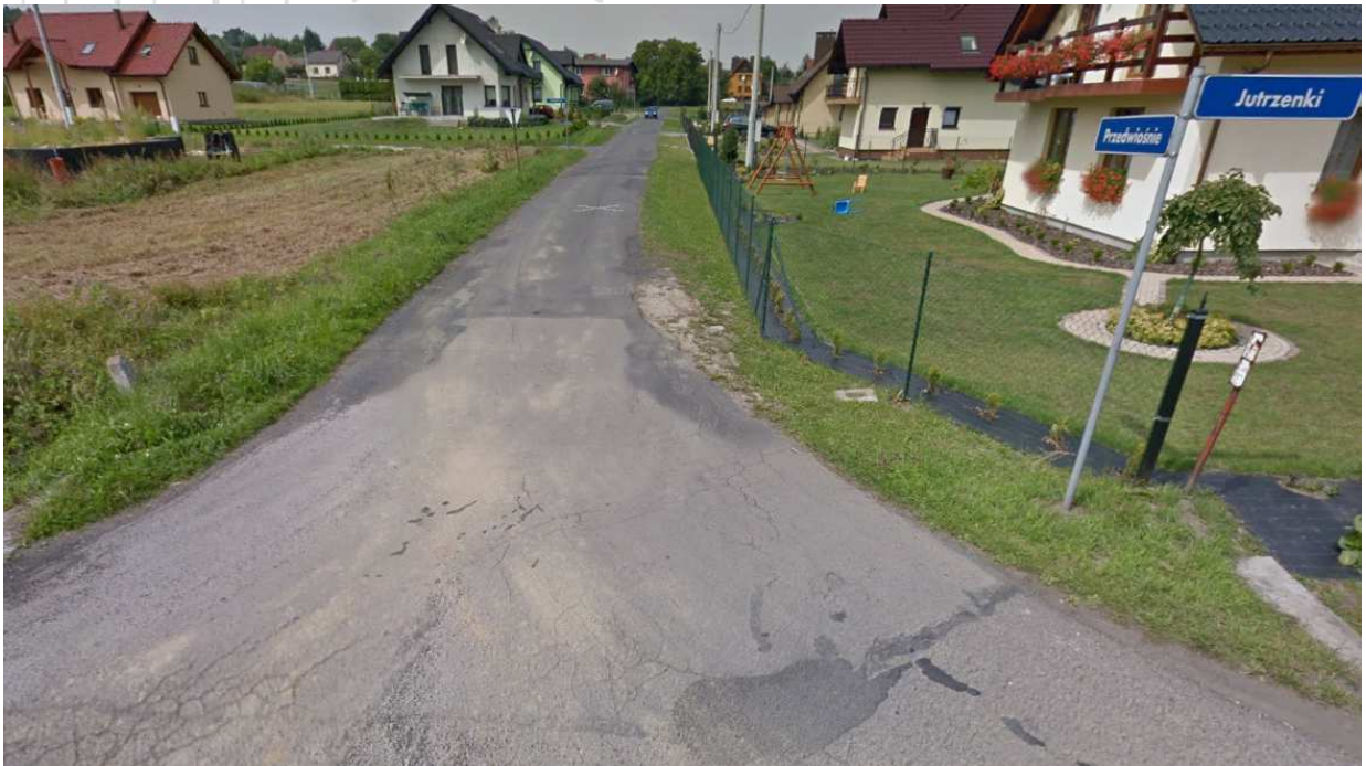
Skrzyżowanie ulicy Jutrzenki z ulicą Przedwiośnie
