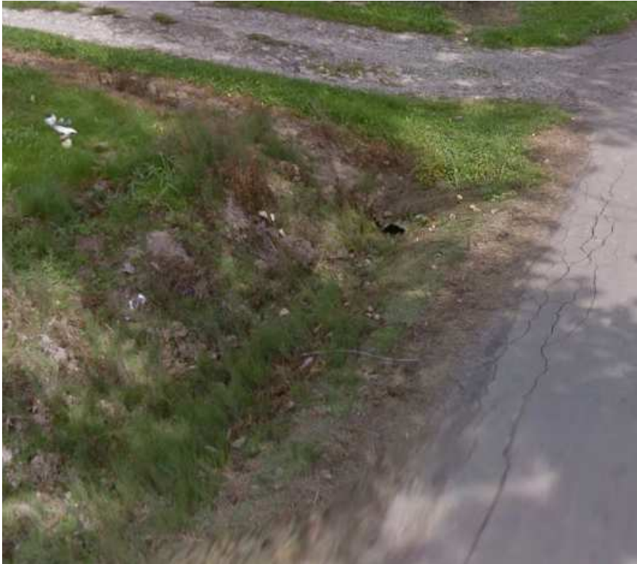
Widoczne spękania krawędziowe oraz niedrożny przepust pod zjazdem
